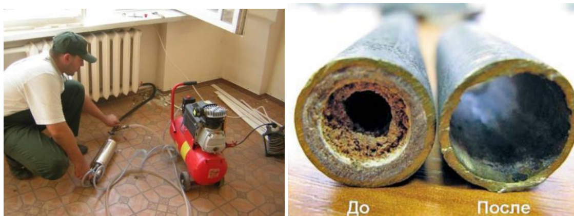
Рисунок 3 - Промывка батареи
